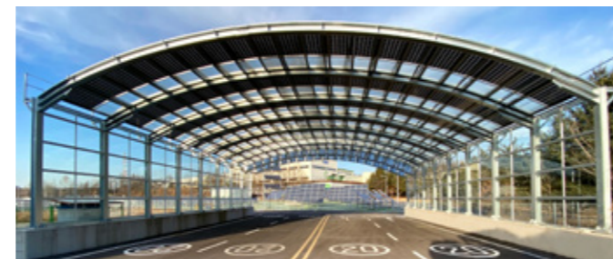
방음벽, 터널형 태양광 발전 시스템
