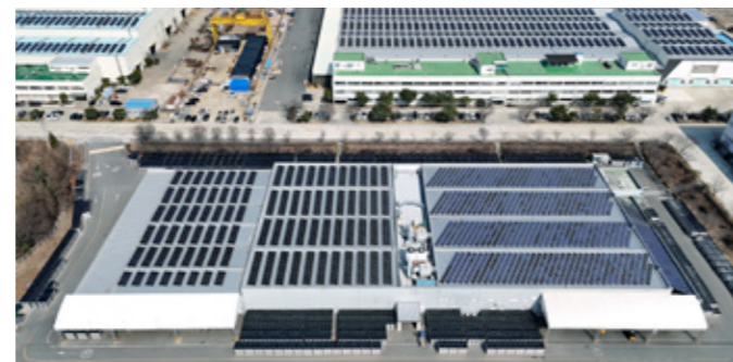
음성 모듈 3공장 발전소 전경
